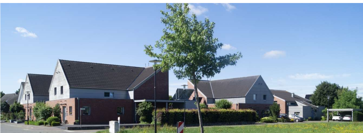
Auf Privatinitiative entstandene kleine Passivhaus-Siedlung aus 7 Häusern im Orsbecker Feld (Baujahr 2001)
